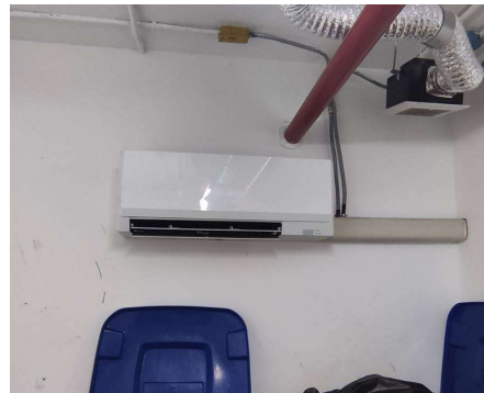
ระบบระบายอากาศห้องพักมูลฝอยประจำชั้น
